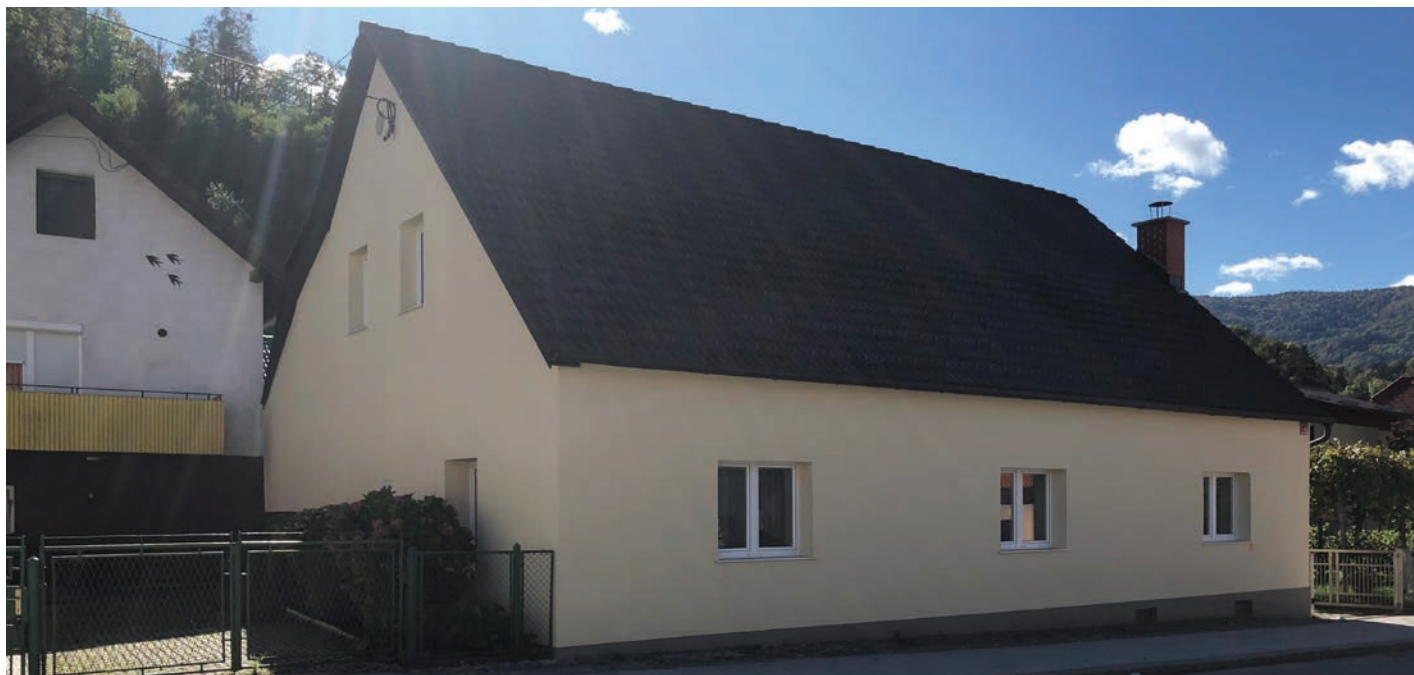
Foto: Obnovljena fasada na Mariborski cesti v območju naselbinskega spomenika
